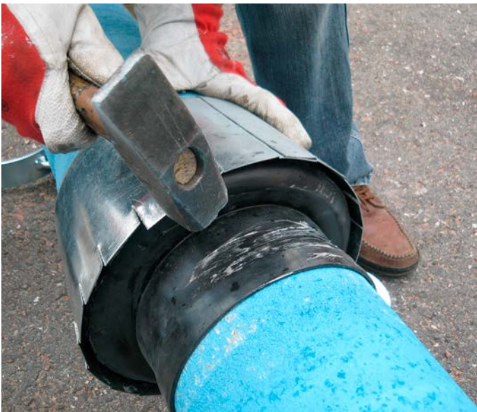
Kuva 11. Naputtele suojapelti paikalleen.
