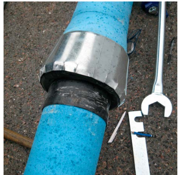
Kuva 12. Liitos on valmis vedettäväksi.
