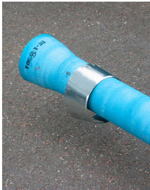
Kuva 2. Aseta suojakaulus putken päälle ennen vetopään kiinnittämistä ja liitoksen tekemistä. Huom. Vetotyökalun vaatima asennustila oltava riittävä (ks. kuva 7)
