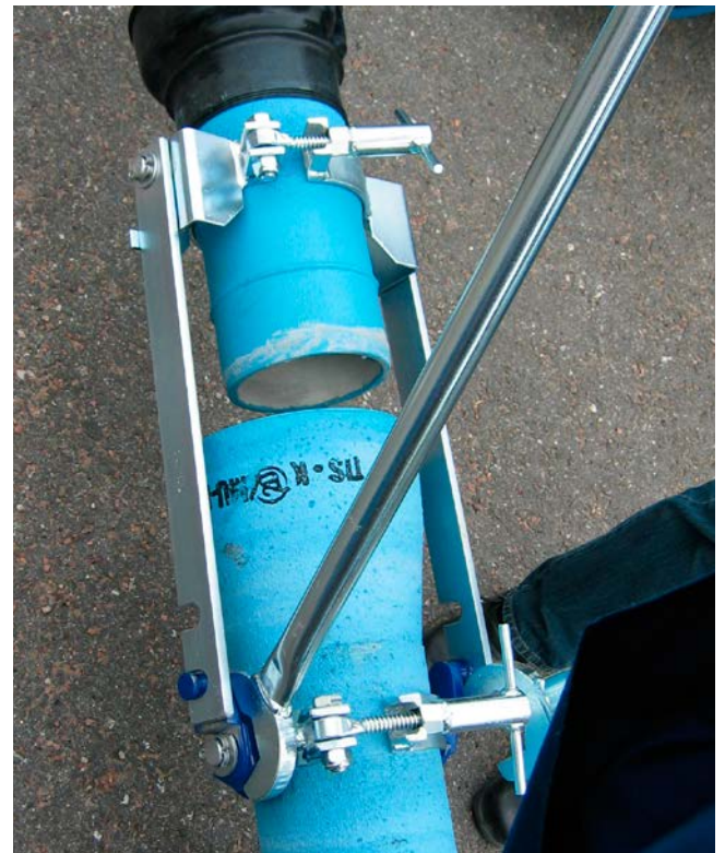
Kuva 9. Käytä vipuvartta liitoksen tekemisessä. Varmista, että lukkorengas asettuu pistopäähän hyvin, eikä siirry edellä työnnettäessä.
