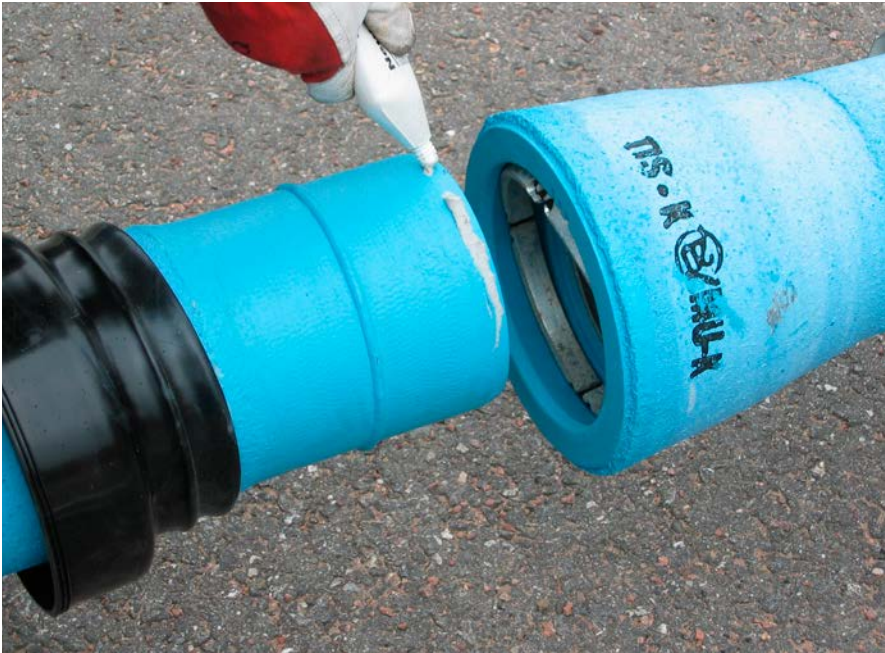
Kuva 7. Sivele liukuainetta tiivisteeseen ja pistopäähän.
