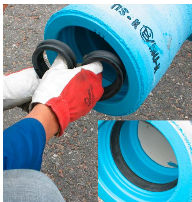
Kuva 4. Laita tiiviste paikoilleen. Varmista, että tiiviste on asettunut hyvin uraansa.
