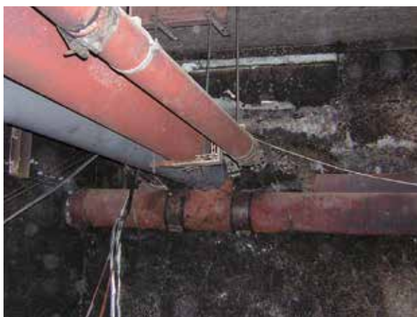
Palotestissä valurautainen PAM-viemärointijärjestelmä pysyi paikallaan toimintakykyisenä.
