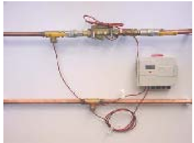
Kuva 2: Laskin asennettuna seinälle
