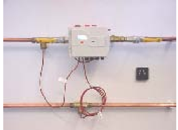
Kuva 1: Laskin asennettuna virtausmittarin päälle
